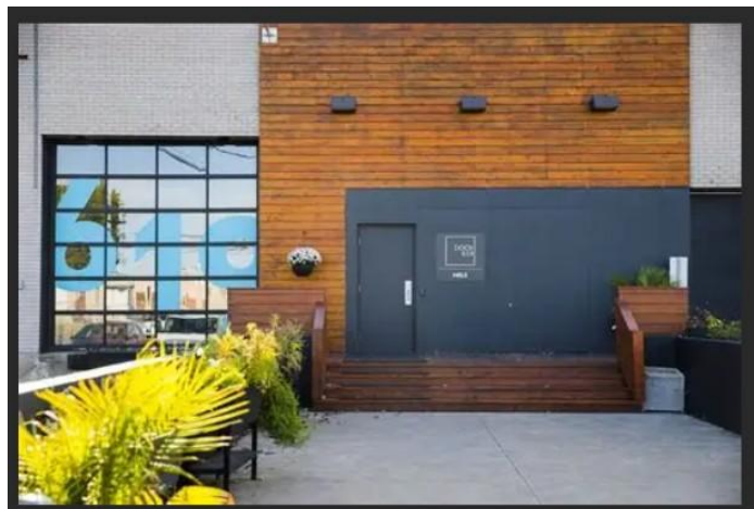
Porte d'entrée à l'arrière de l'édifice
